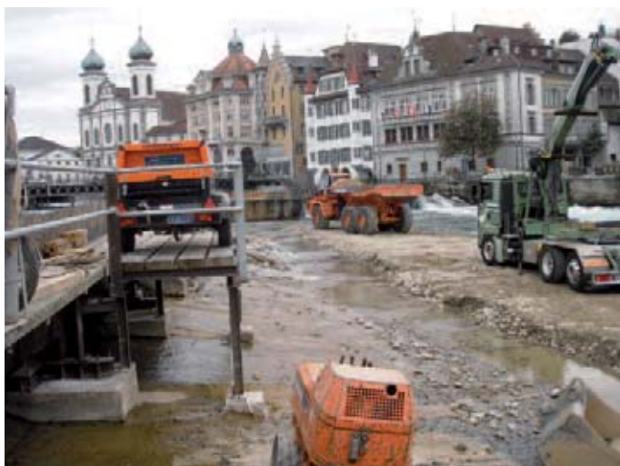
Baupiste Längsnadelwehr
