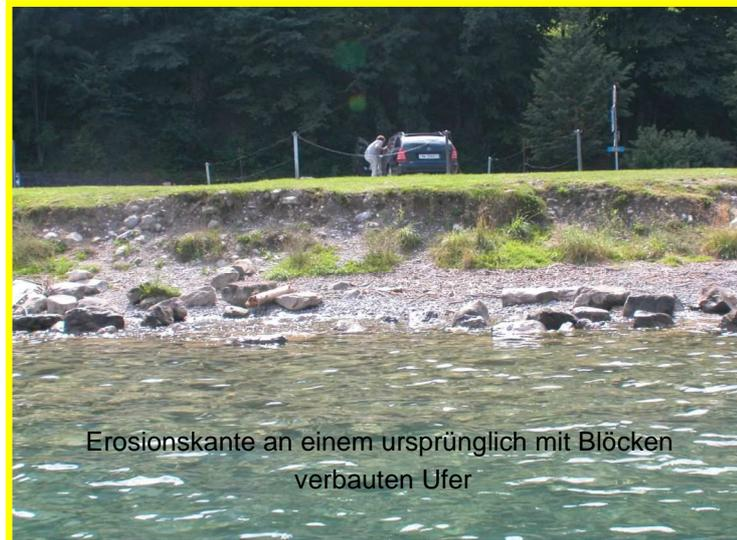
Erosionskante an einem ursprünglich mit Blöcken verbauten Ufer
